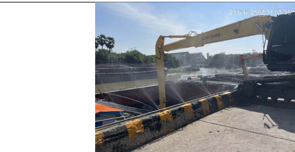
ระบบสเปรย์น้ำบนขอบท่าเทียบเรือ
