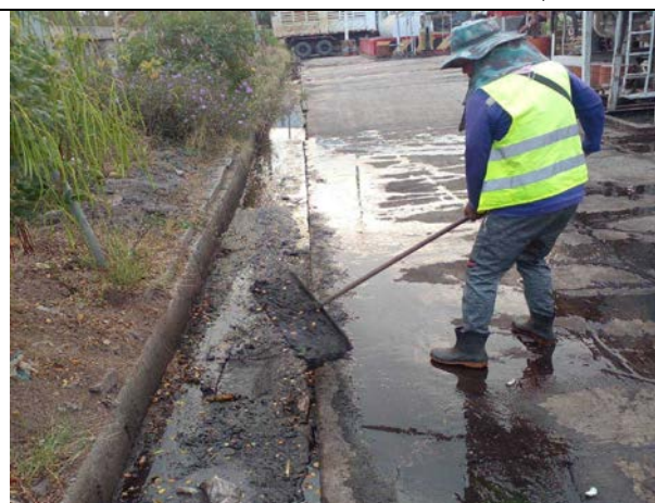
การขุดลอกรางระบายน้ำ (ฝั่งสำนักงานบริษัท ธนวัชรต้นมงคลขนส่ง จำกัด)
